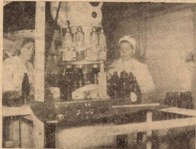
A palacköltő automata gépsora úgyszólván minden fizikai munkától megmenti a melletük dolgozó asszonyokat. Az üres üvegeket felrakják, a tel-
